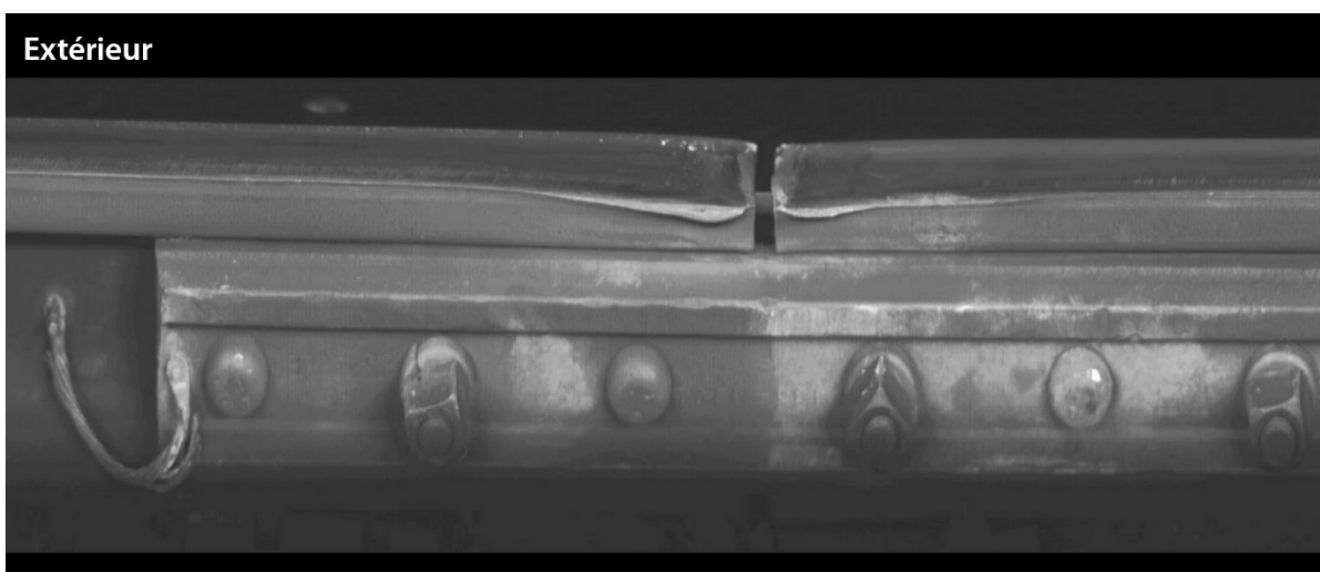
Figure 9. Éclisse ordinaire du côté extérieur (point milliaire 197,4751) montrant l'écrasement des champignons aux abouts de rail (Source : Compagnie des chemins de fer nationaux du Canada)
