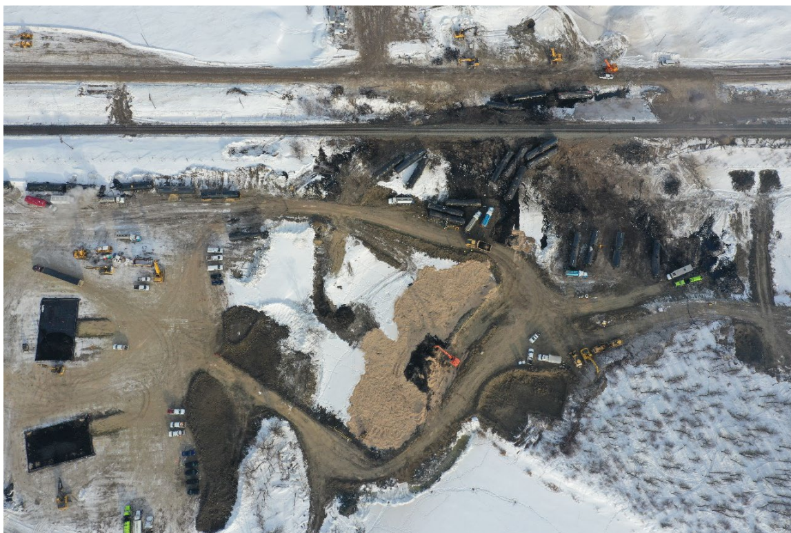
Figure 7. Vue aérienne des activités d'assainissement du site (Source : GHD)
