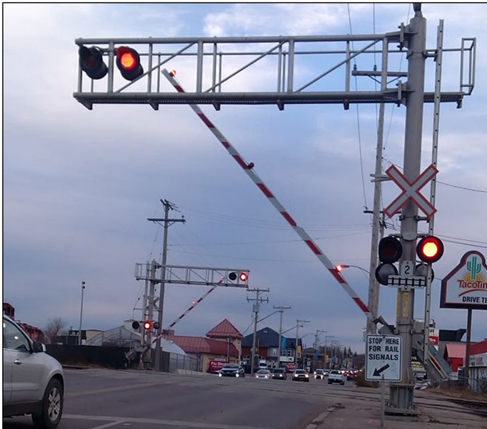
Figure 3. Photo montrant l'angle des barrières sur l'avenue Central 10 secondes après le déclenchement du système d'avertissement du passage à niveau
