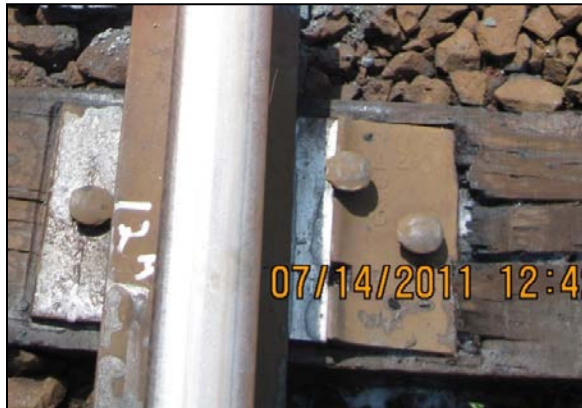
Photo 3c. Vue rapprochée d'une entaille ancienne faite par un anticheminant dans la traverse et la selle, ainsi qu'un polissage vertical/horizontal plus récent sur la face d'appui de l'anticheminant
