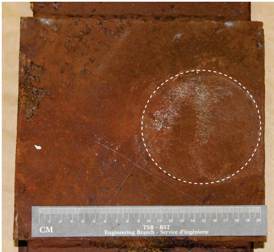
Photo 5. Plaque d'appui de l'axe d'attelage montrant l'excentricité de la marque d'usure
