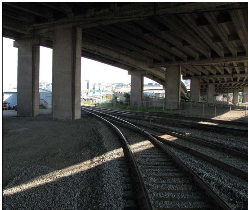
Photo 1. Vue vers l'ouest de l'approche du branchement E18
