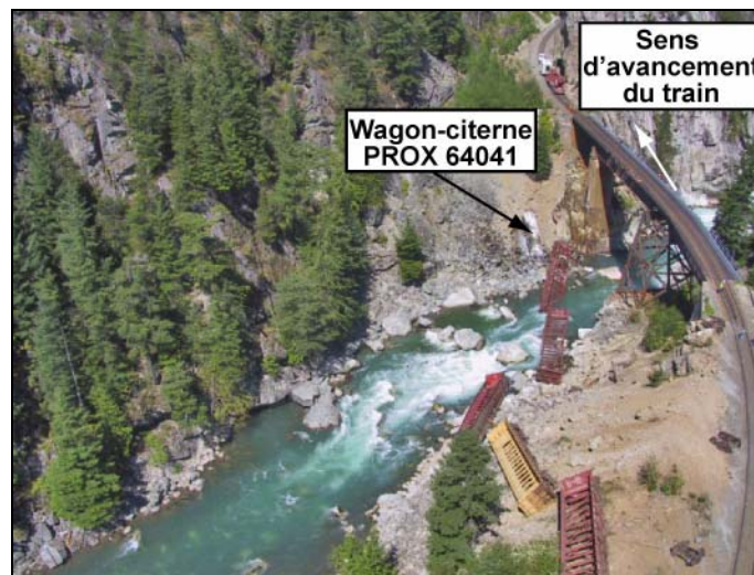
Photo 1. Position du wagon-citerne après le déraillement
