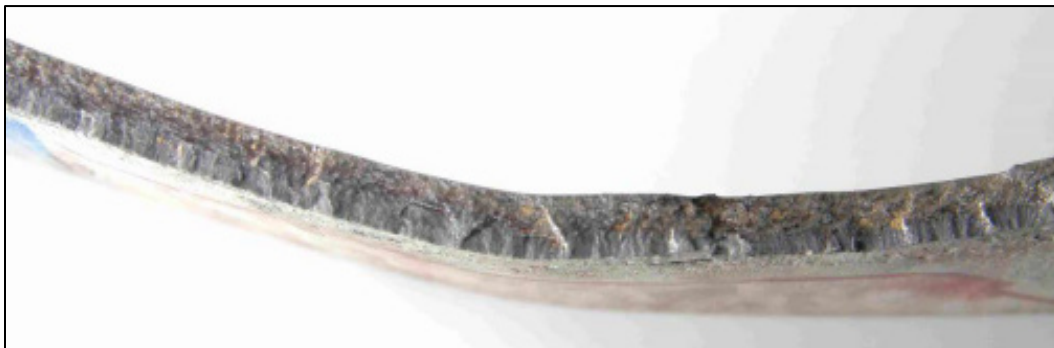
Figure 8. Fissures en interaction sur une partie du fragment 1 de la conduite rompue (Source : Acuren)
