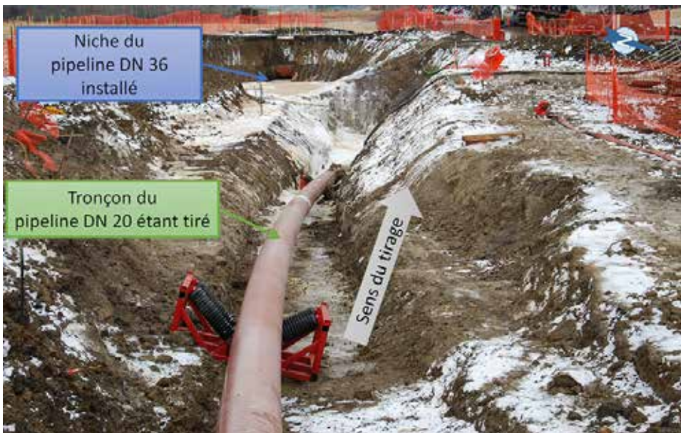
Figure 5. Tronçon du pipeline de DN 20 au point d'entrée de l'opération de tirage
