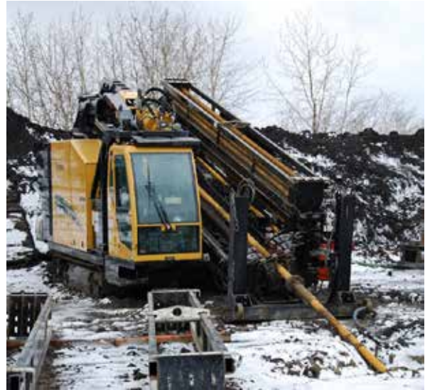
Figure 6. Outil de forage utilisé pour tirer le pipeline GRP de DN 20
