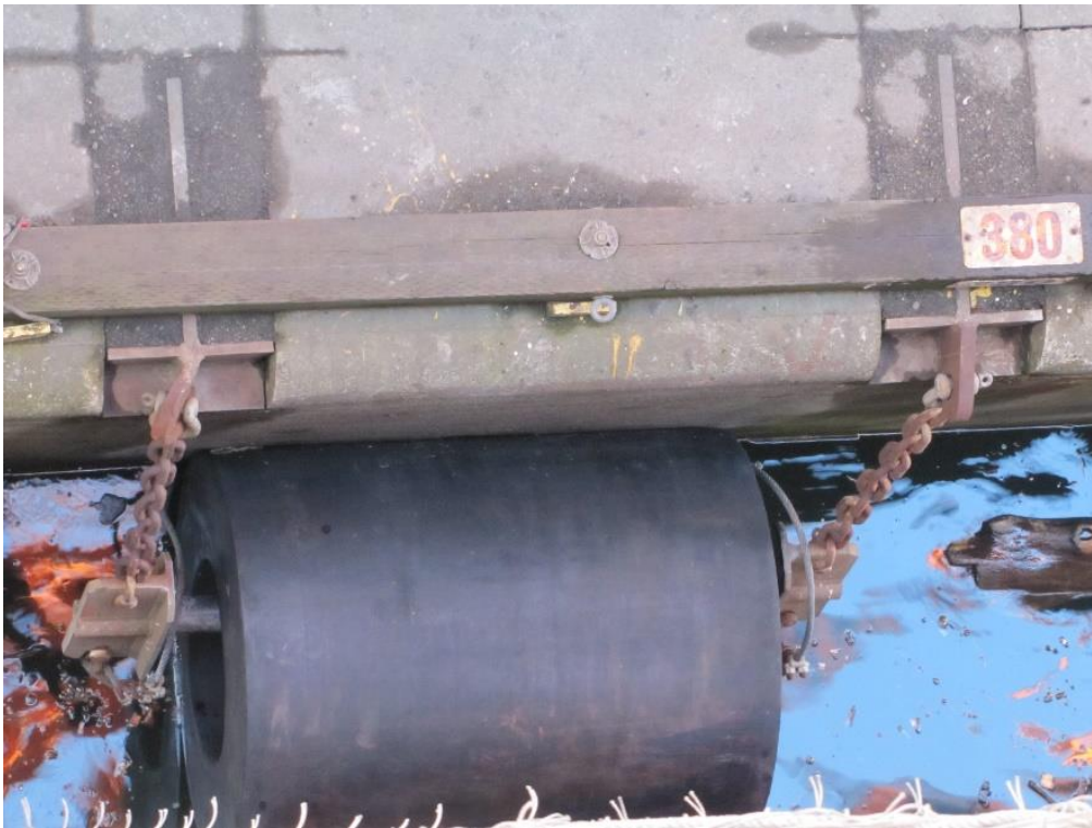
Figure 8. Défense cylindrique au poste d'accostage 5 de Vanterm (Source : BST)
