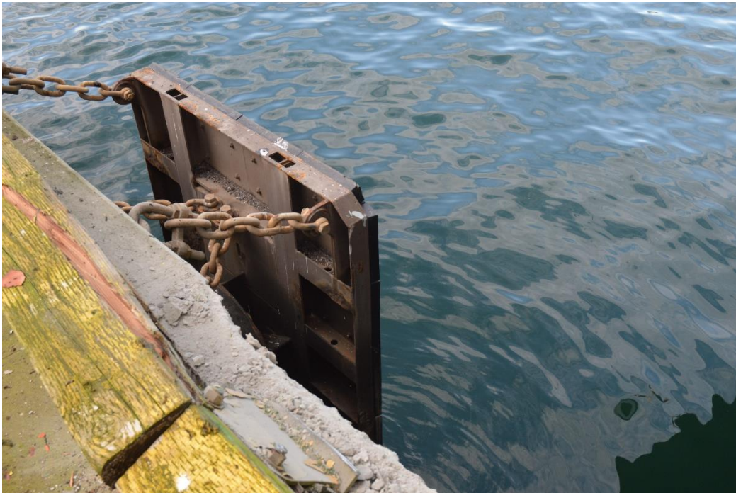
Figure 9. Défenses coniques sur l'agrandissement du poste d'accostage 6 de Vanterm (Source : BST)
