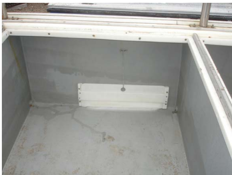
Photo 6. Sabord de décharge avec plaque coulissante, vu de l'intérieur du bateau
