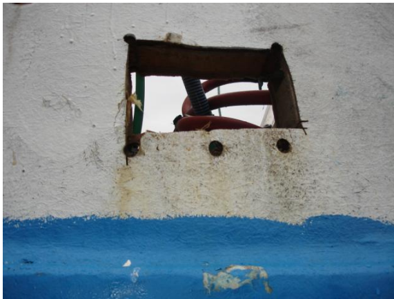
Photo 2. Sabord de décharge découpé à la main
