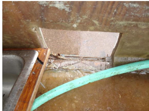
Photo 3. Sabord de décharge découpé à la main
