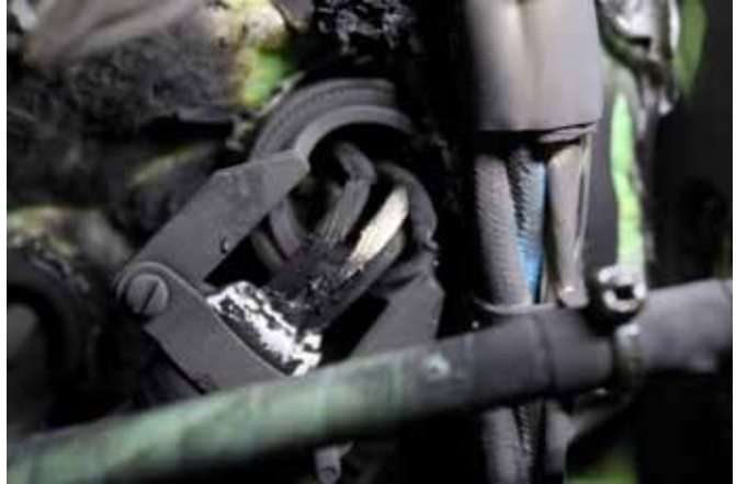
Figure 3. Connecteur électrique 9811-J711 sur l'aéronef en cause dans l'événement à l'étude
