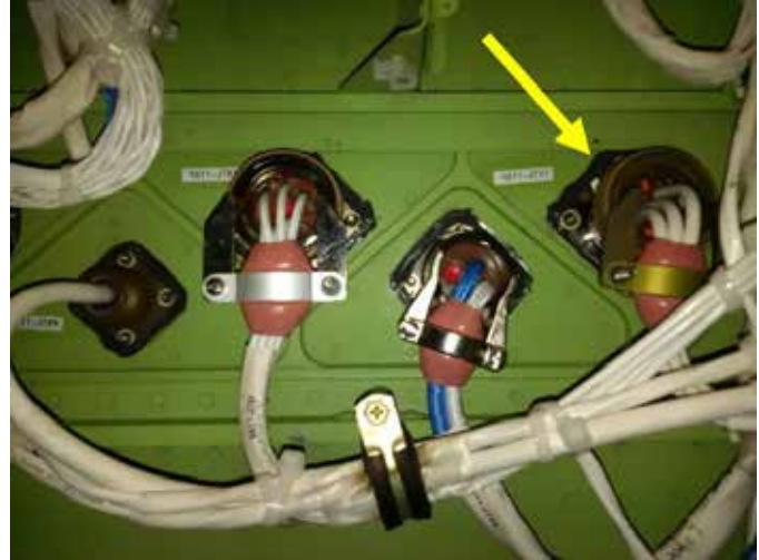
Figure 1. Connecteur 9811-J711 désigné par la flèche (Source : Bombardier Aéronautique, avec annotations du BST)
