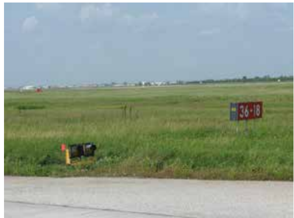
Photo 2. Panneau de point d'attente et feux de protection de piste (côté droit) vus de la voie de circulation Victor
