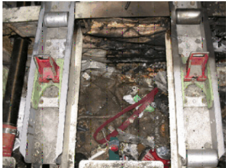
Photo 4. Matelas d'isolation contaminés et débris
