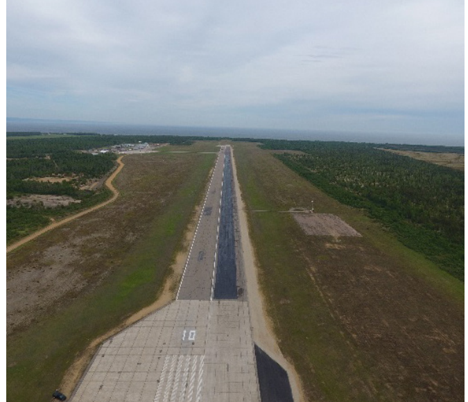
PHOTO 1. Aéroport en voie de réfection
