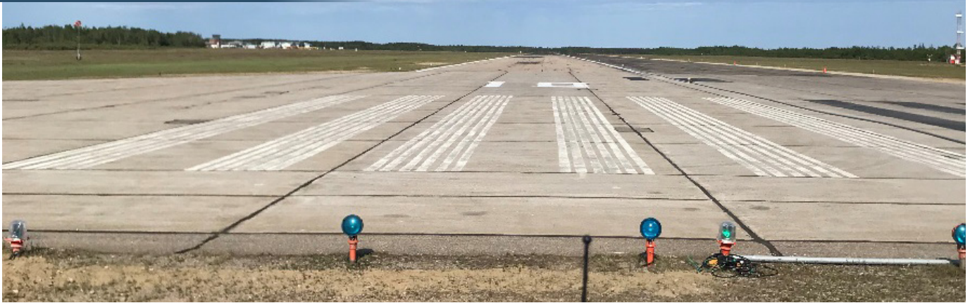
PHOTO 4. Piste en voie de réfection
