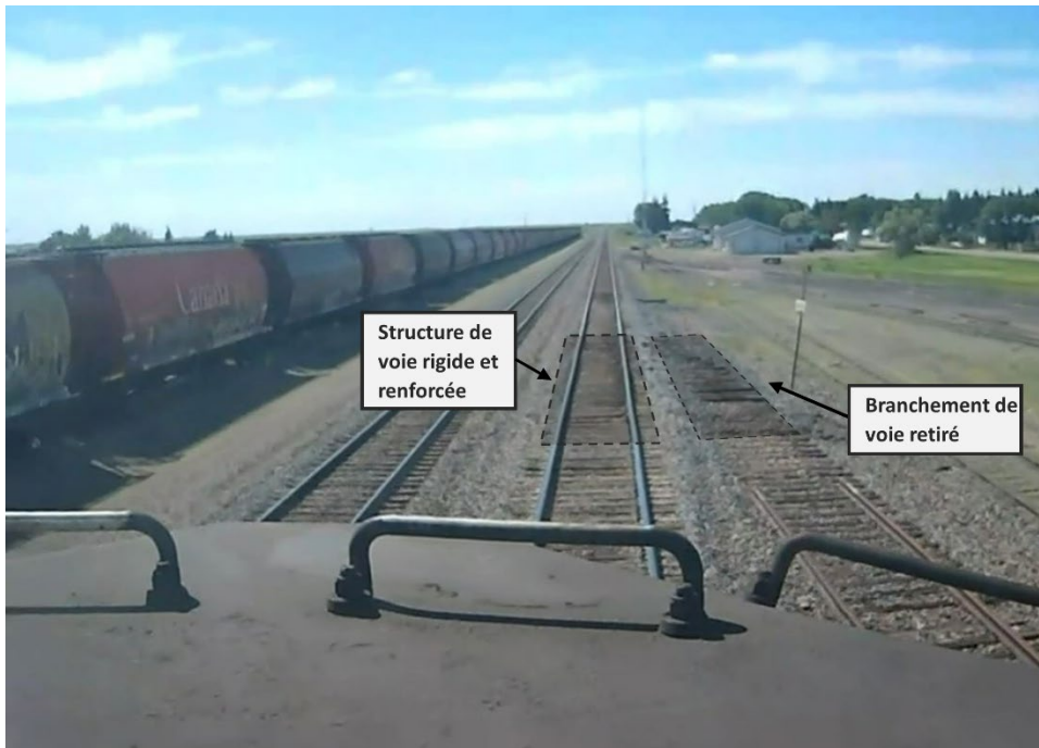
Figure 5. Vue de l'endroit où le branchement de voie a été retiré au point milliaire 97,48, à partir de la locomotive de tête du train (Source : Canadien Pacifique, avec annotations du BST)
