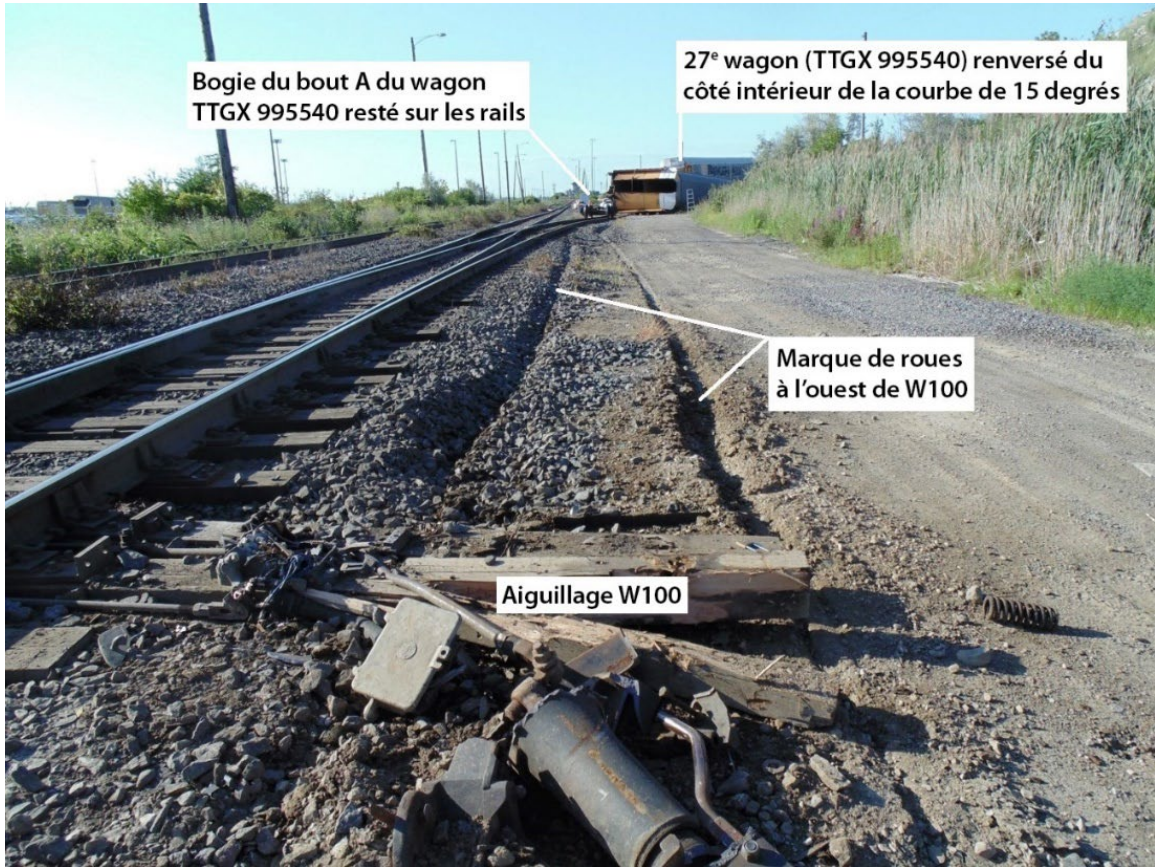
Figure 6. Vue vers le sud à partir de l'aiguillage W100 (Source : BST)
