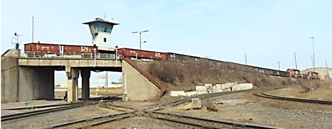
Figure 3. Triage à butte à la gare de triage MacMillan (Source : BST)
