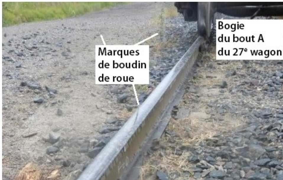
Figure 11. Marques de boudin de roue sur le champignon de rail et dans le ballast (Source : BST)
