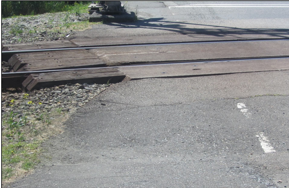
Figure 3. Prolongement de la surface de croisement au passage à niveau public de la rue Broadway (Source : BST)
