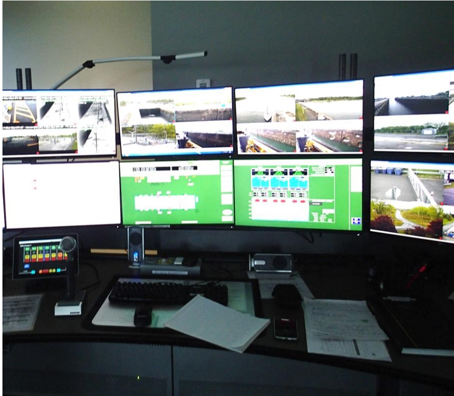
Figure 3. Poste de travail d'éclusier
