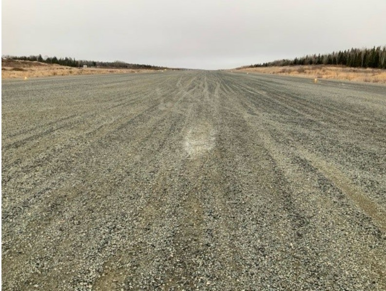
Figure 2. Marque d'impact faite par le fuselage de l'aéronef montrant le point d'impact sur la piste 29 (Source : Aéroport de Sandy Lake)
