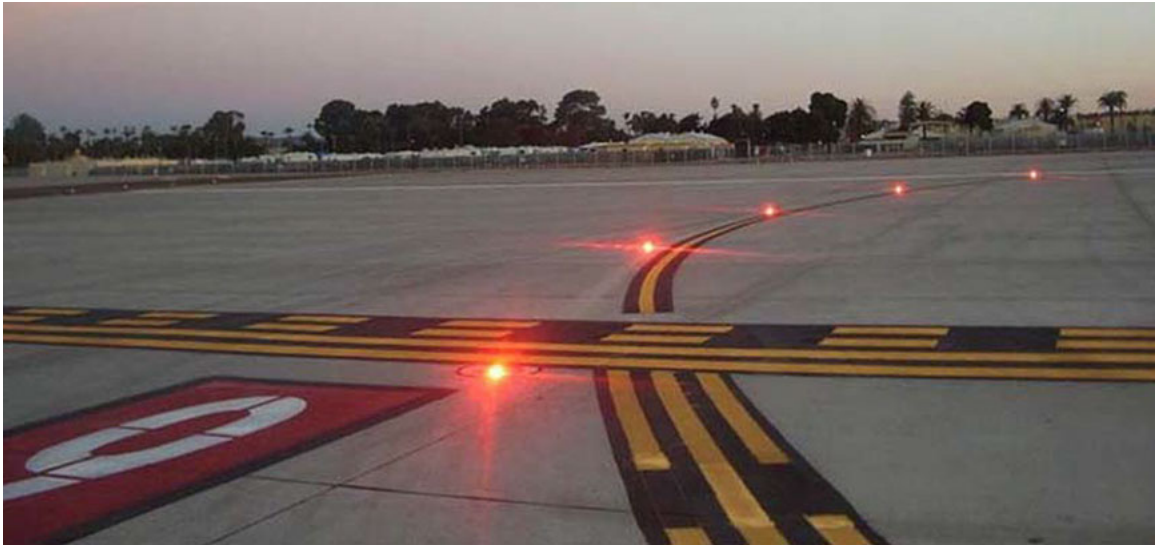
Figure 22. Exemple de feux d'entrée de piste allumés (Source : Federal Aviation Administration des États-Unis, « Runway Status Lights Photo Gallery », à l'adresse https://www.faa.gov/air_traffic/technology/rwsl/gallery [dernière consultation le 31 décembre 2018])
