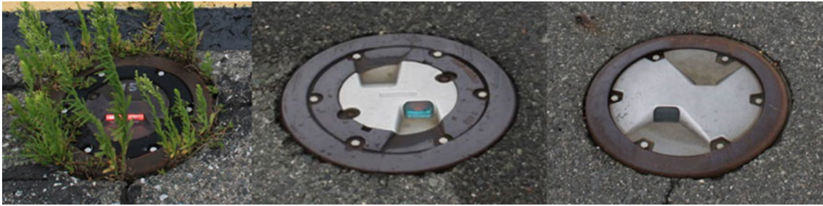
Figure 16. Photo composite montrant des feux occultés, des mauvaises lentilles et des ampoules défectueuses
