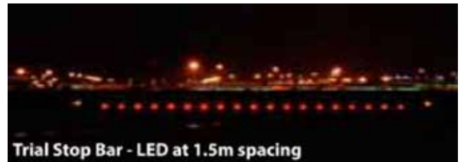
Figure 10. Espacement réduit des feux DEL (Source : EUROCONTROL, Hindsight 19 [2014], p. 18)
