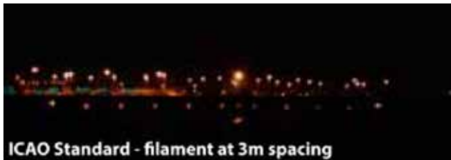
Figure 9. Espacement standard de l'OACI des feux de barre d'arrêt (Source : EUROCONTROL, Hindsight 19 [2014], p. 18)
