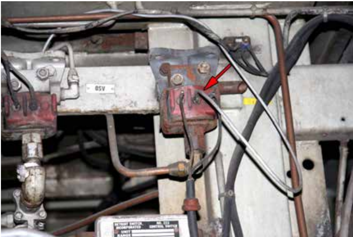
Figure 7 : Raccordement en vue de l'essai de frein sur la locomotive 5023
