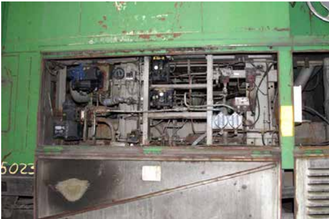
Figure 6: Compartiment du frein à air de la locomotive 5023
