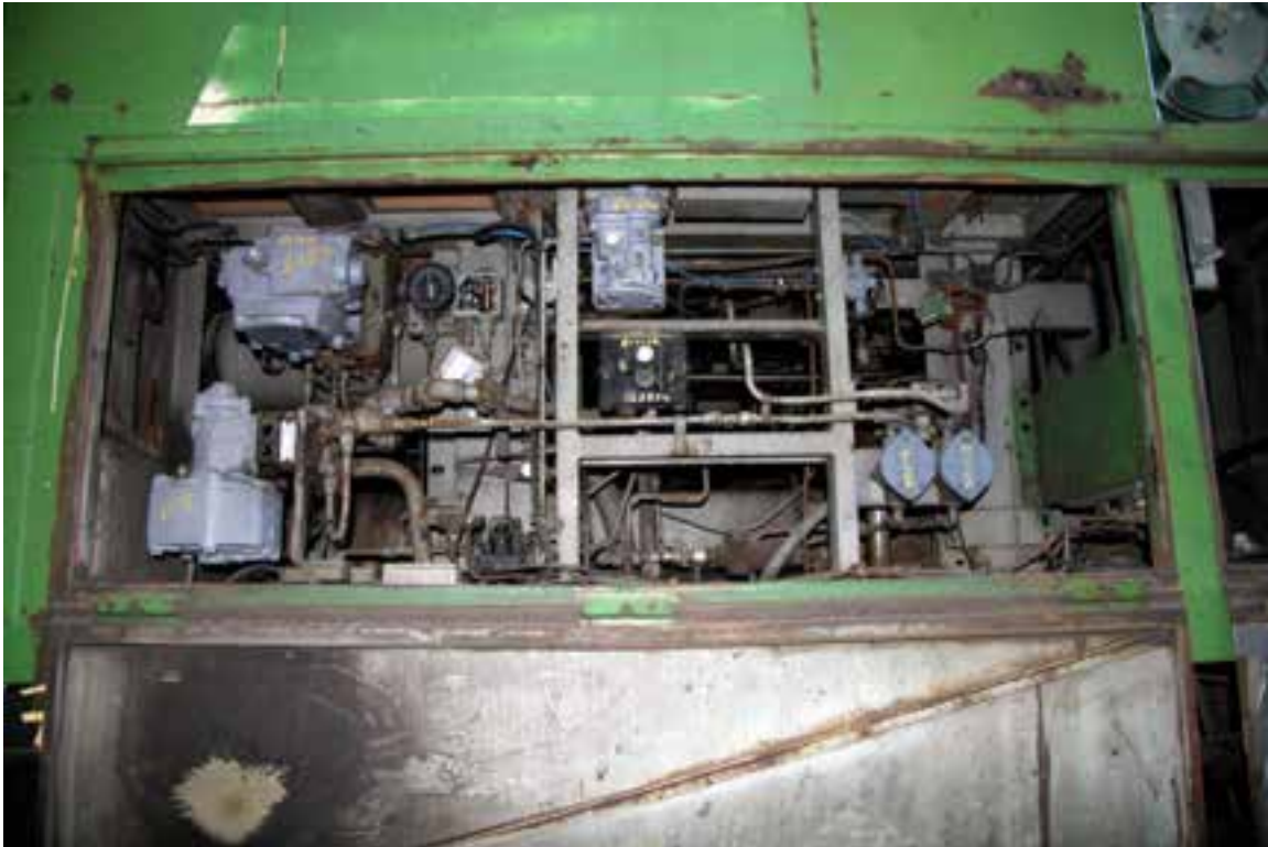
Figure 1: Compartiment du frein à air de la locomotive 5017
