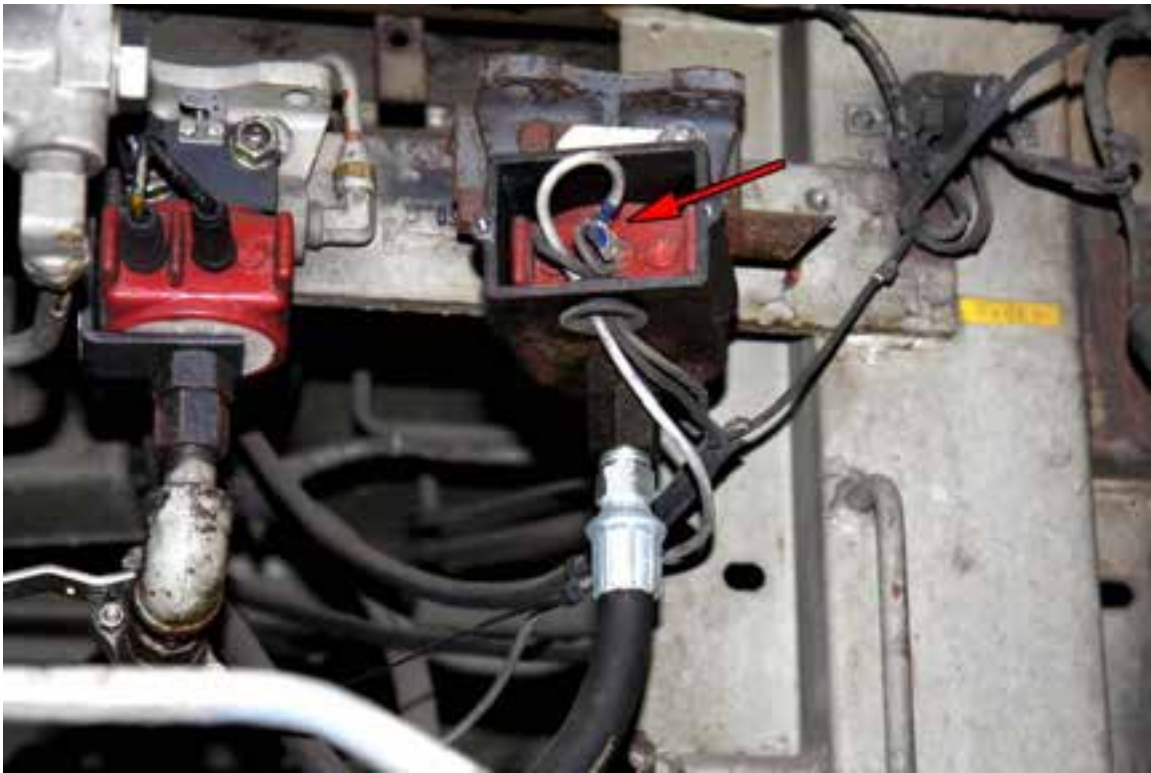
Figure 9: Raccordement en vue de l'essai de frein sur la locomotive 5026
