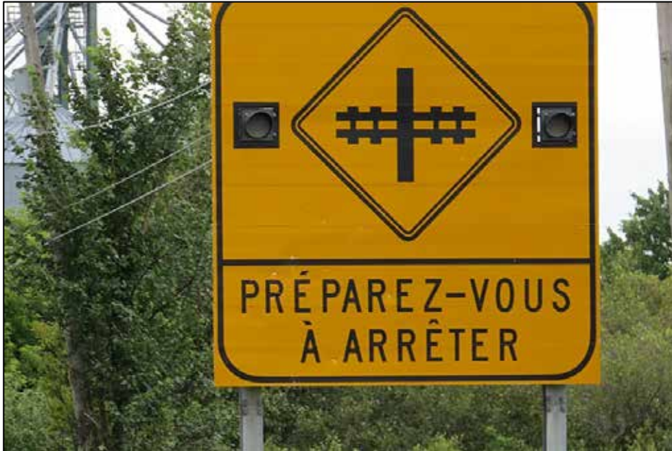
Figure 2. Panneau de signalisation avancée actif
